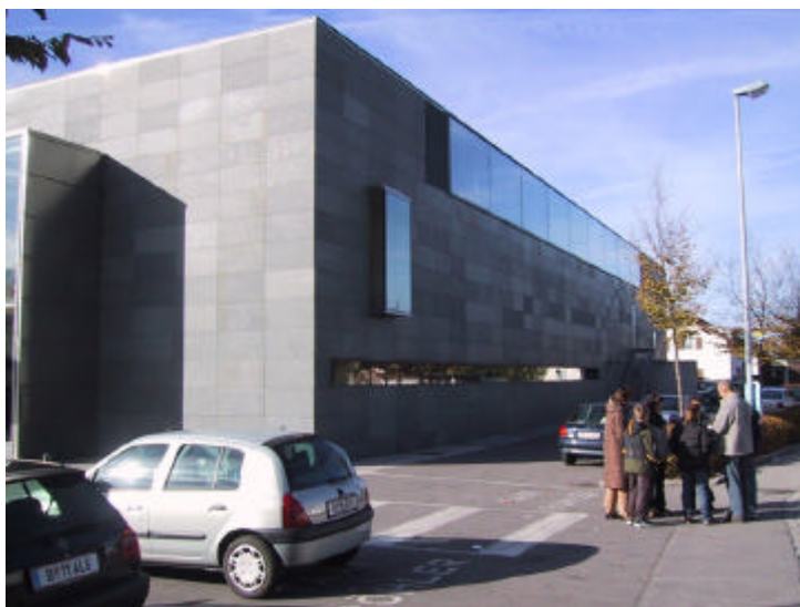
Abbildung 1.5: Cubus Wolfurt: Nordseite
