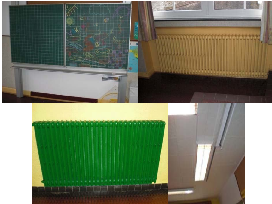
Abb. 120: Resonierende Gegenstände in Klassenräumen: Tafel, Heizkörper und Lampen.
