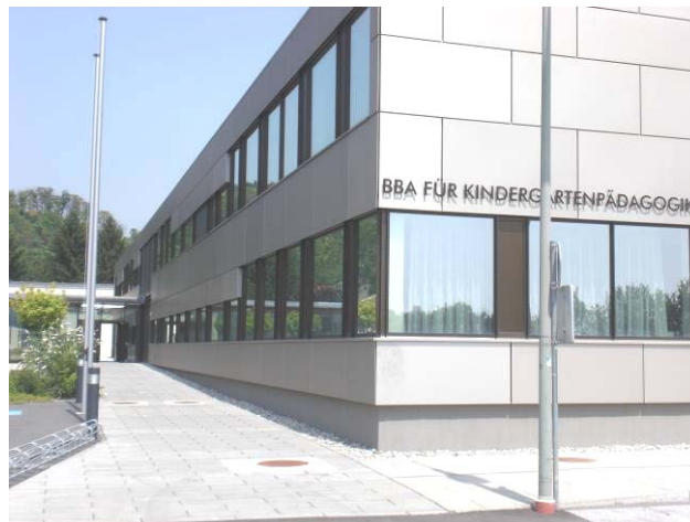
Abb. 186: Bundesbildungsanstalt für Kindergartenpädagogik (Grottenhofstrasse, Graz): Neubau und Deckensanierung aus dem Jahr 2007.
